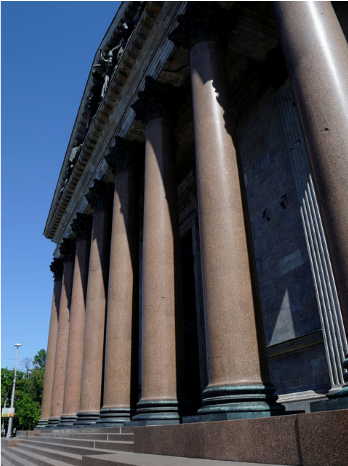
Rys. 29: masywne, monolityczne kolumny z granitu.
