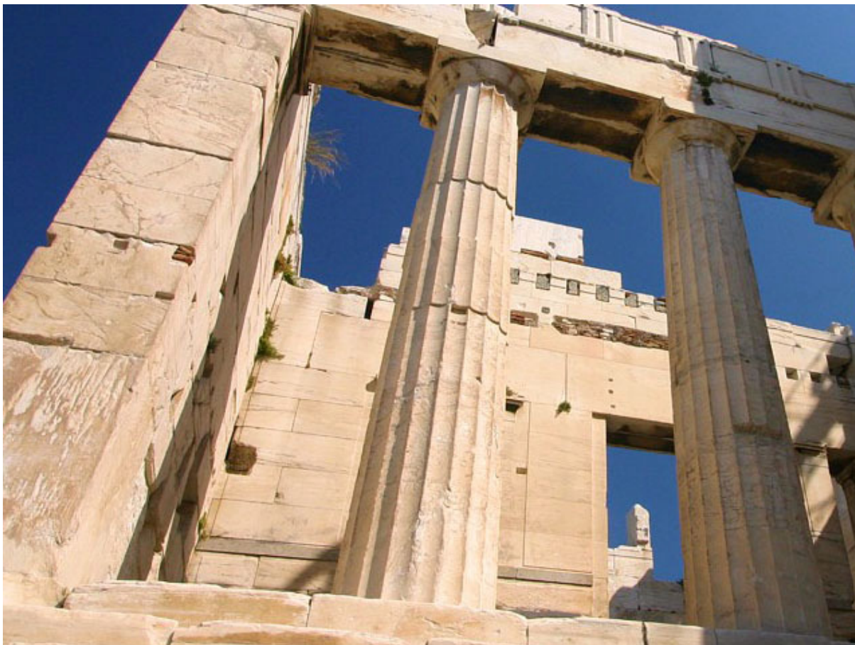
Rys. 18: w pełni marmurowa budowla na Akropolu w Atenach.
