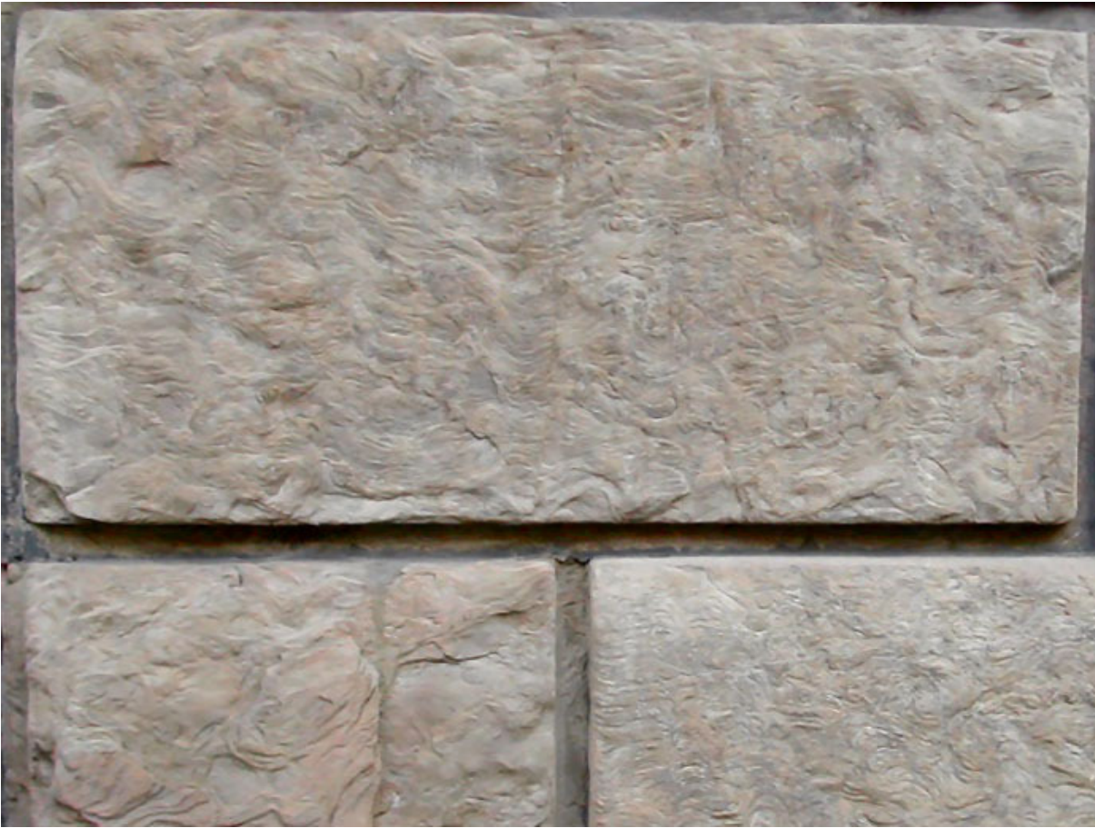
Rys. 13: powierzchniowe uwarstwowanie płyt piaskowca, Florencja (Włochy).
