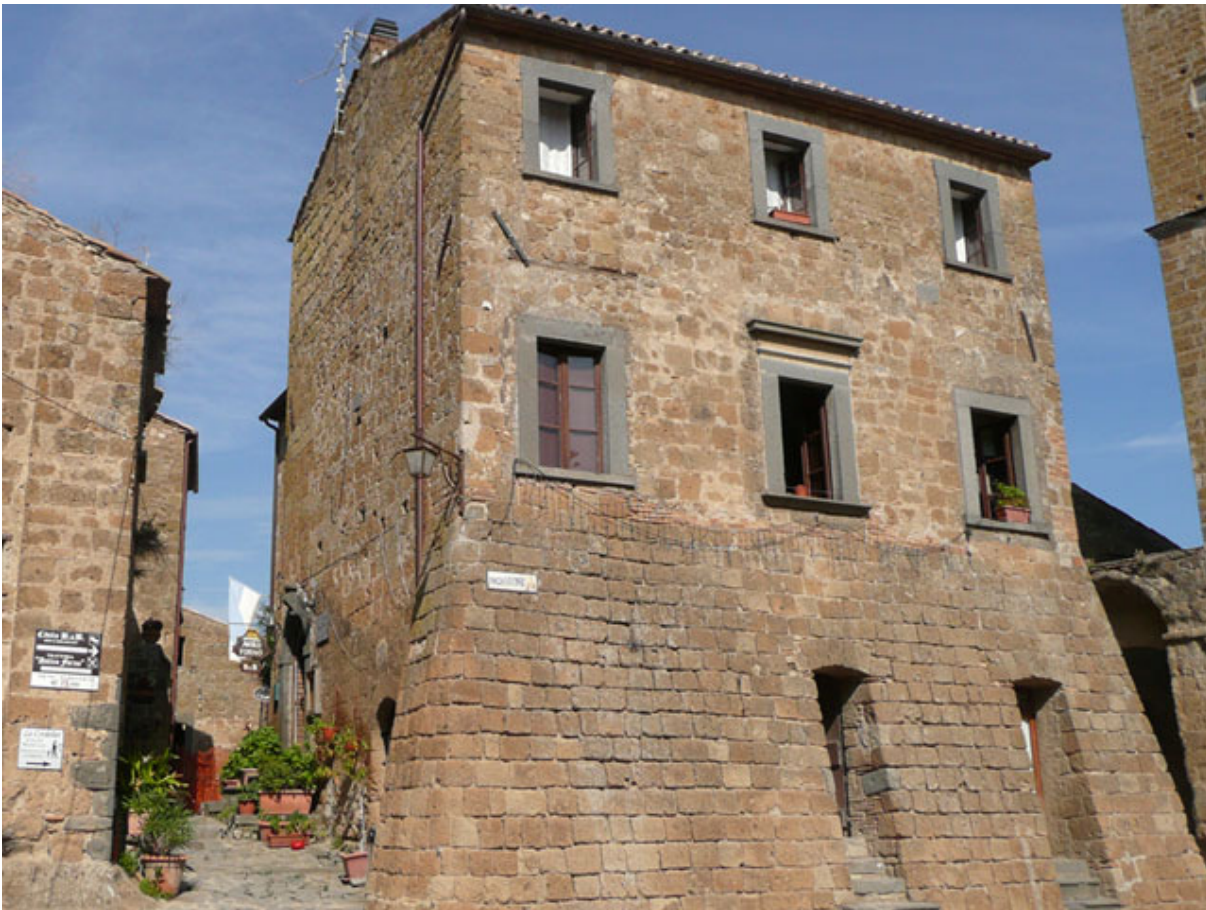
Rys. 27: budynki wykonane w całości z bloczków skały tufowej, Lazio (Włochy).
