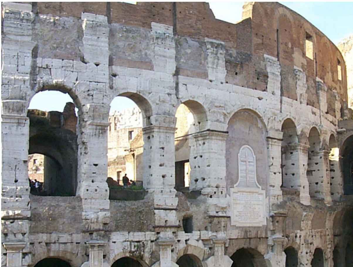
Rys. 10: bloki trawertynu o różnych kształtach i rozmiarach w Koloseum, Rzym (Włochy).
