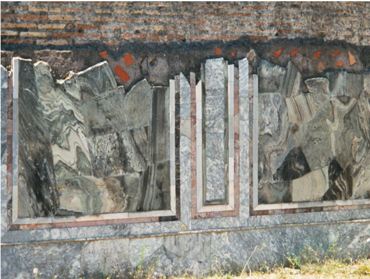
Rys. 19: pokrycia marmurowe na surowej ścianie ceglanej, Ostia (Rzym, Włochy).
